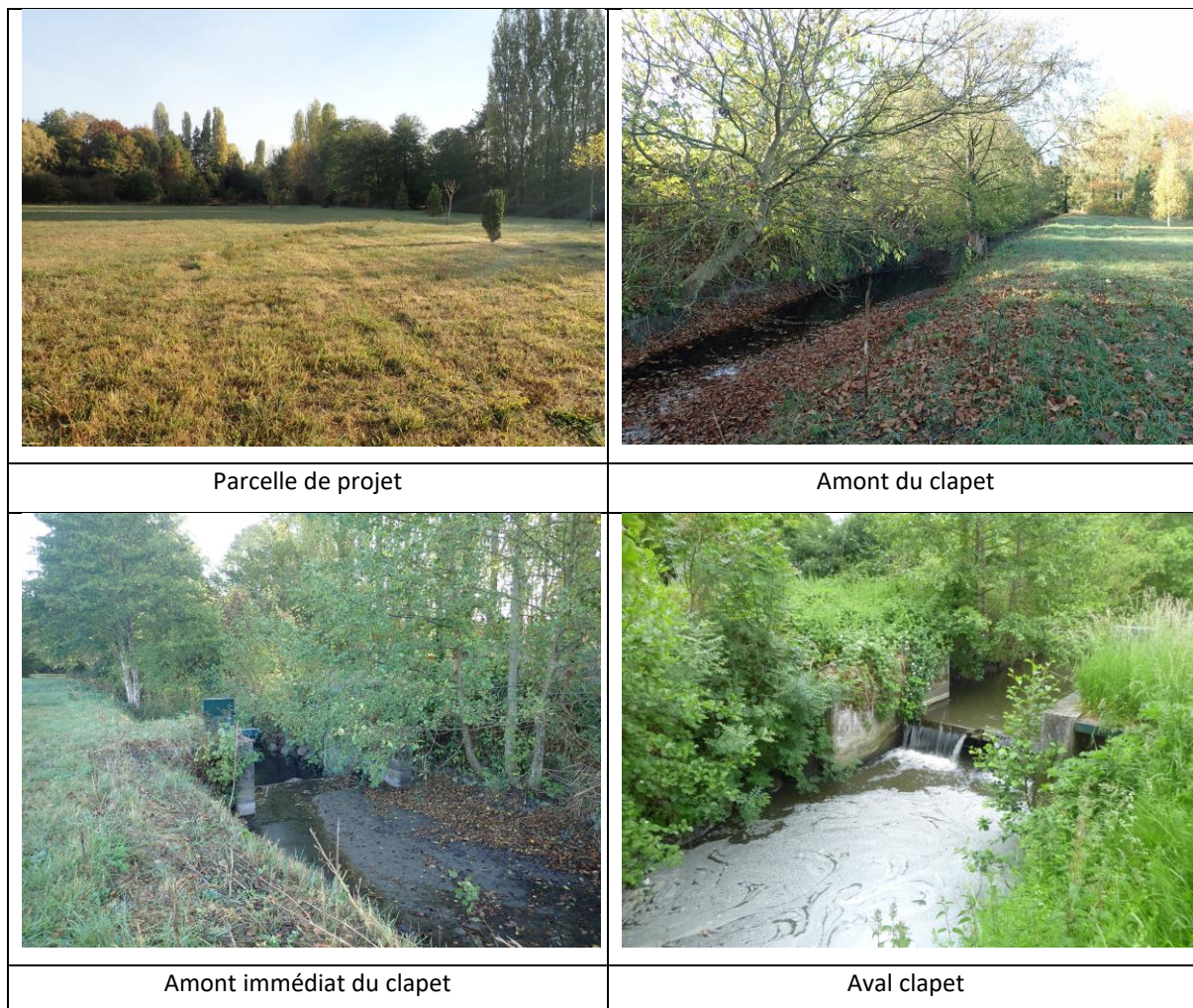
Figure 2 : Photographies du site (SEGI, 2018/2019)
